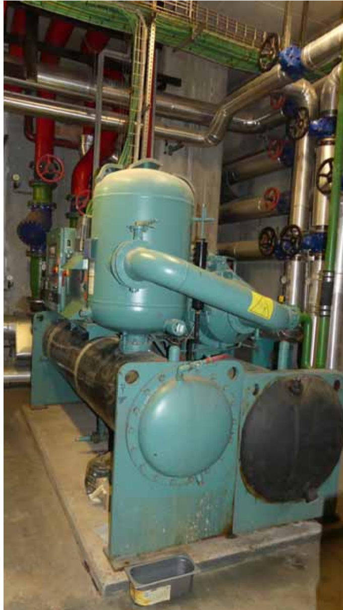
Kompressionskälteanlage Gruppo frigorifero a compressione
