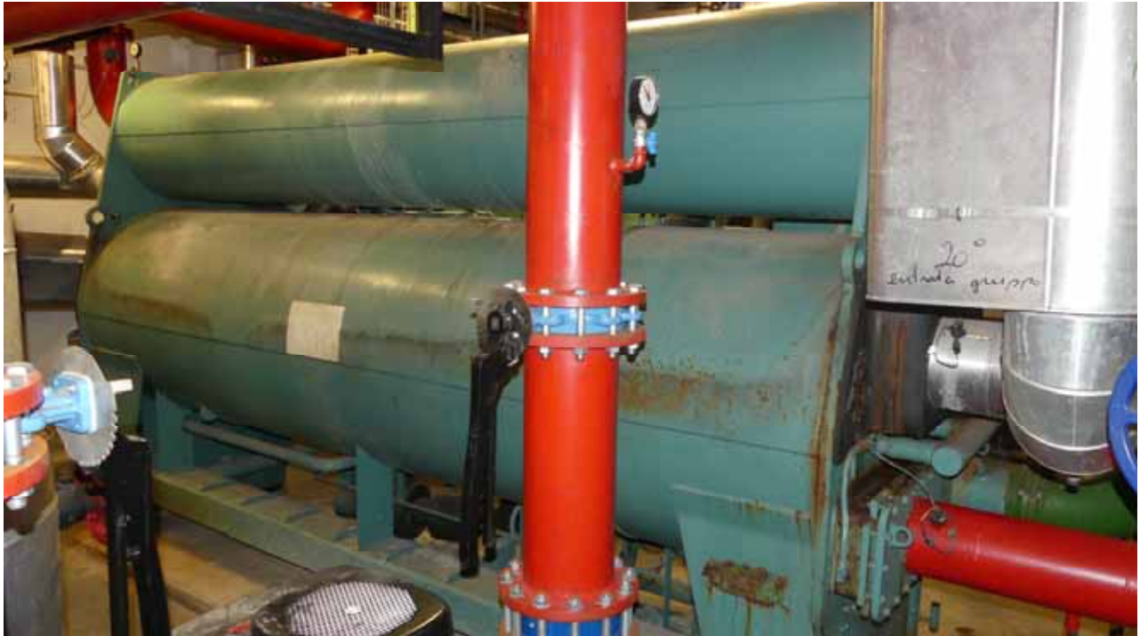
Absorbtionskälteanlage Gruppo frigorifero ad assorbimento
