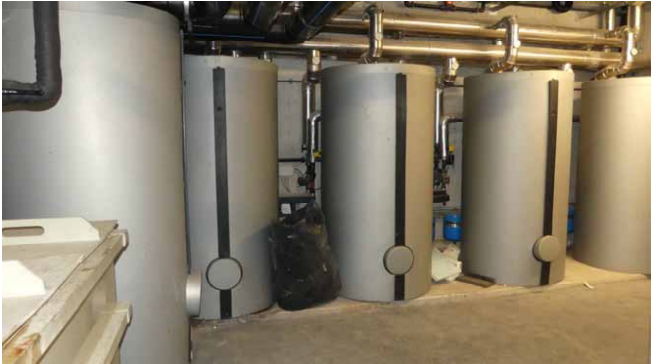
Speicher für Wärmeückgewinnung Acumuli per recupero di calore
