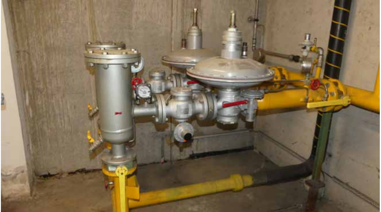
Methangas - Druckregler Regolatori di pressione gas metano
