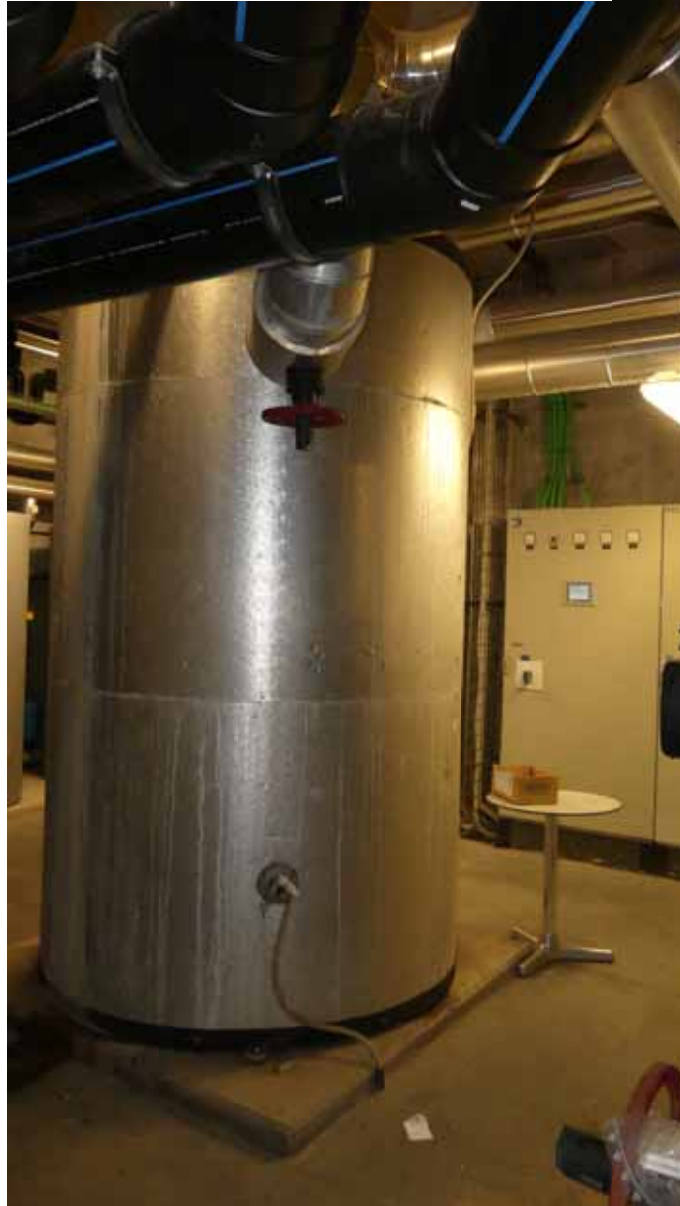
Kältepuffer Accumulo di freddo
