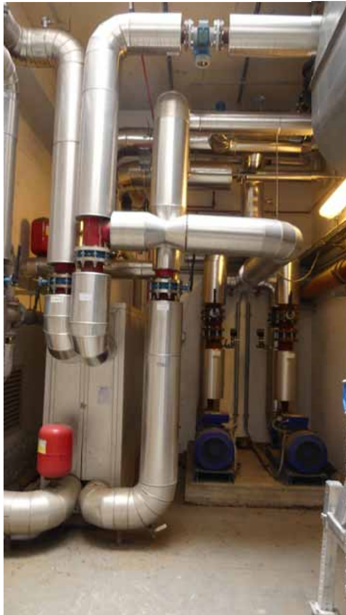
Übergabestation Fernwärme Stazione di consegna teleriscaldamento
